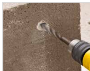
Perfuração em concreto
