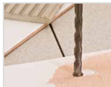
Perfuração em cerâmica
